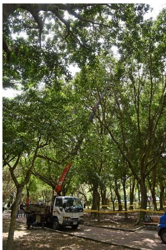
圖 1. 2022 年巢位監視器安裝過程
