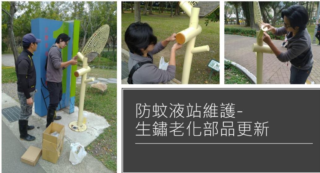
圖二十一、生鏽部分新品更換。
