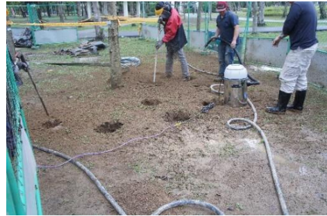
照片 2-42 用吸塵器搬出土壤
