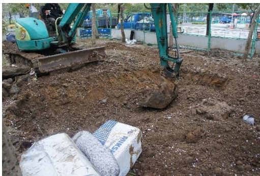
照片 2-35 鄰接的現場土壤使用于改良用土壤
