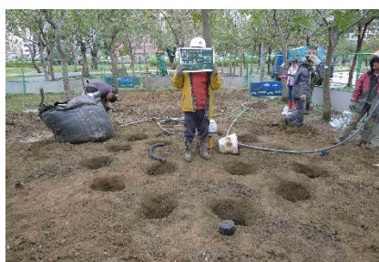
2) 點穴挖掘完成
