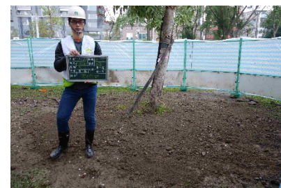
6) 土壤改良土回填完成
