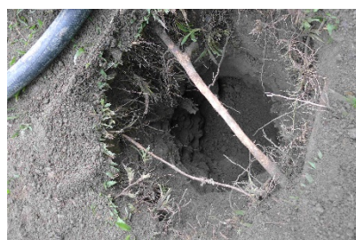
5) 點穴（ \phi 40\text{ cm} \times \text{深 } 60\text{ cm} ）
