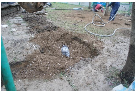
照片 2-28 回填土壤改良材混合土
