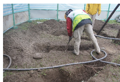
3) 用空氣挖掘機挖掘
