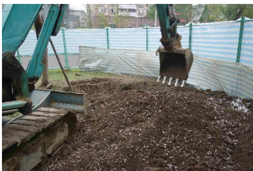
照片 2-10 回填土壤改良材混合土
