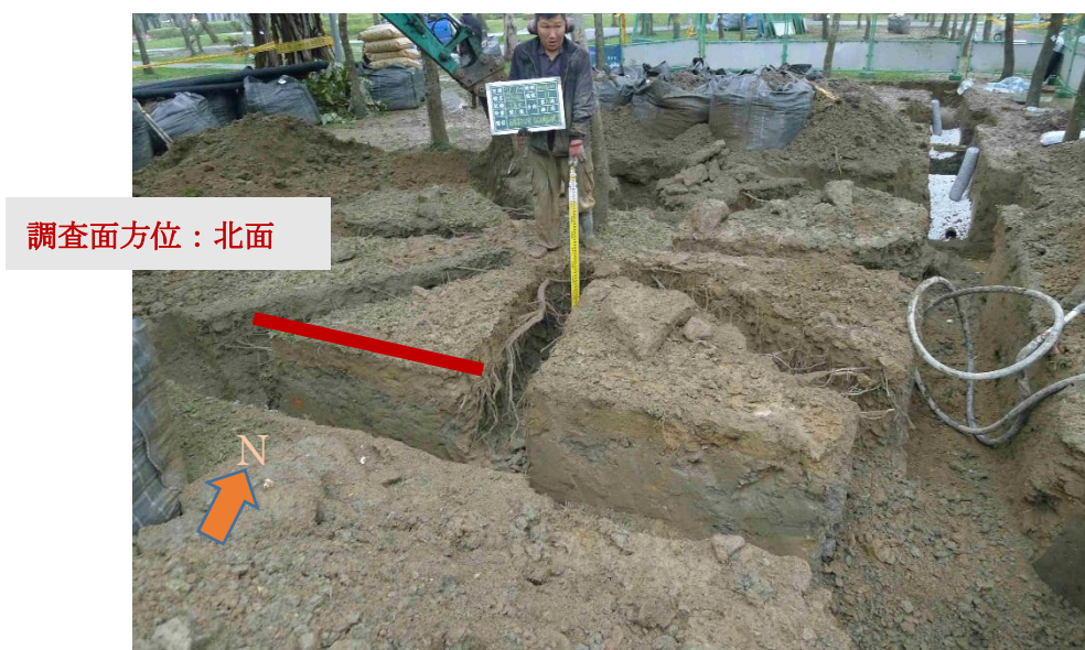
照片 4-5 No.11 挖溝改良（放射狀）、連續溝槽（trench）阿勃勒
