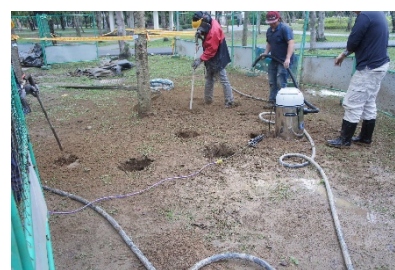
3) 用空氣挖掘機點穴挖掘
