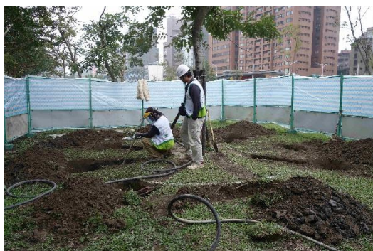
照片 2-16 用空氣挖掘機
