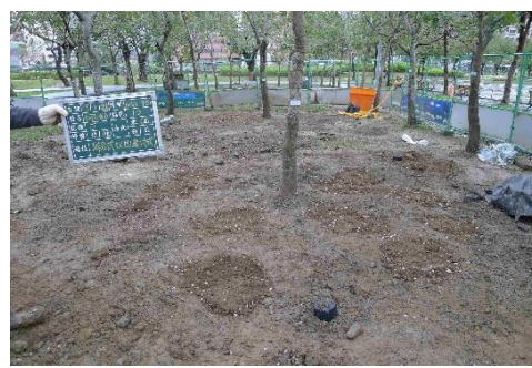
照片 2-45 完成土壤改良
