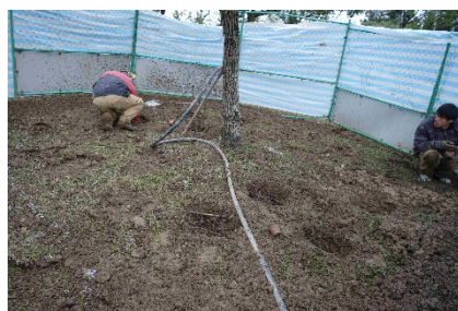
2) 用空氣挖掘機挖掘
