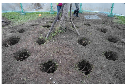
4) 點穴挖掘完成
