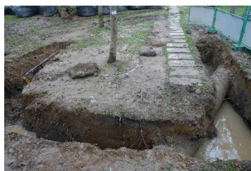
照片 2-59 混凝土管No.10.
