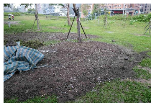
照片 2-11 完成土壤改良
