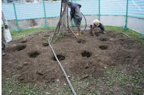
照片 2-41 用空氣挖掘機挖掘
