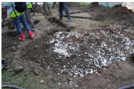
照片 2-18 回填土壤改良材混合土
