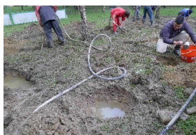
2) 用空氣挖掘機挖掘
