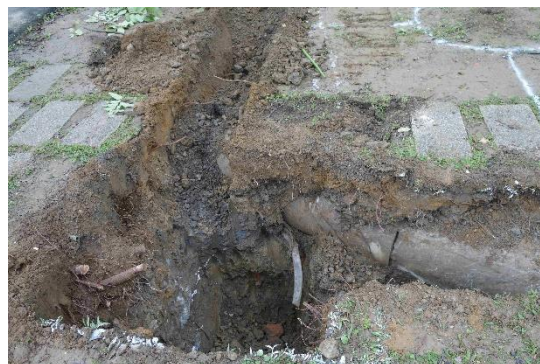
照片 2-31 用怪手挖掘
