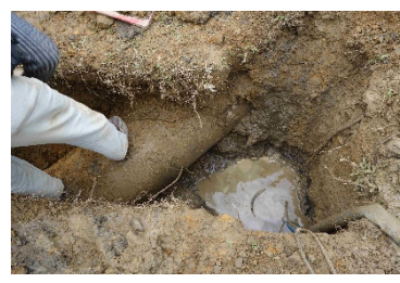
3) 埋設的水泥管
