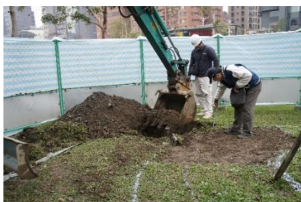
照片 2-6 挖掘土壤排放溝
