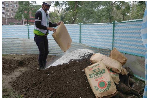
照片 2-9 挖掘的土壤混合土壤改良材
