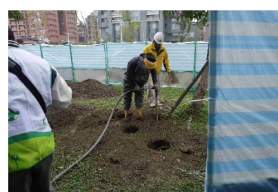
3) 用空氣挖掘機進行挖掘
