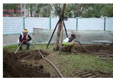
3) 用空氣挖掘機進行扇形挖掘
