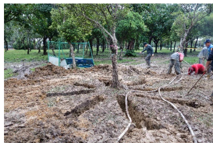
3) 用空氣挖掘機挖溝
