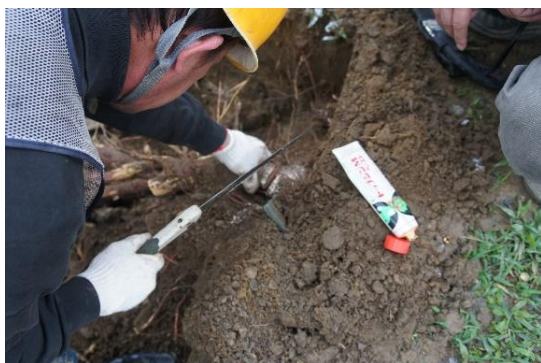
照片 2-32 剪平漏出的根系
