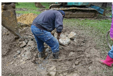
2) 挖掘巨大石礫地土壤
