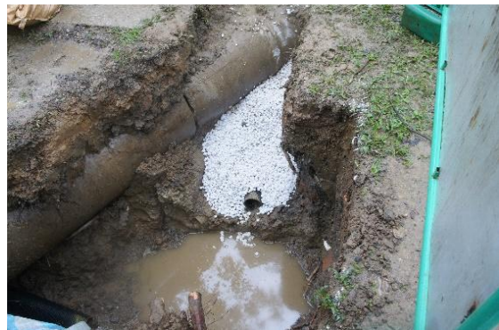
照片 2-25 水泥管下鋪設排水層
