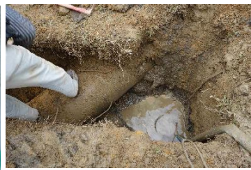
照片 2-61 混凝土管No.20
