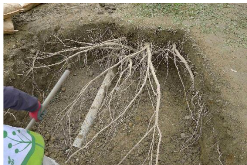
照片 5-2 No.7 區的埋設管
