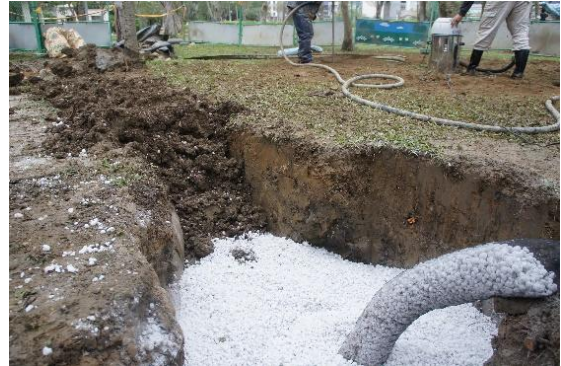
照片 2-34 滲透井設置和酸素管
