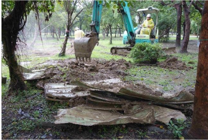
照片 5-4 No.15 榕樹區表層的圍籬鋼板
