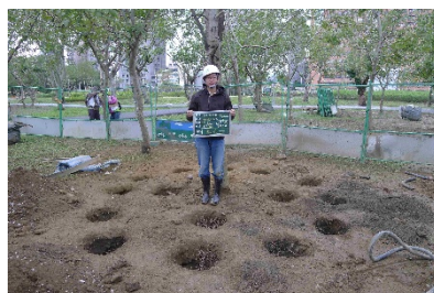
4) 點穴挖掘完成
