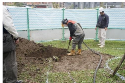
照片 2-7 用空氣挖掘機開始挖掘
