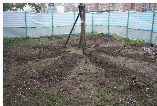
照片 2-19 完成土壤改良
