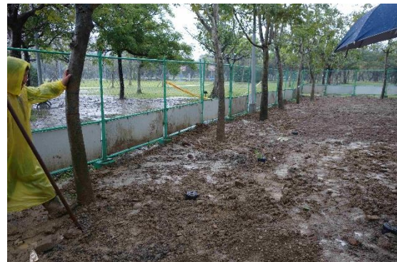
照片 2-29 完成土壤改良
