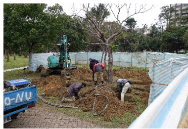
2) 用空氣挖掘機挖掘
