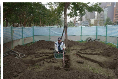
3) 挖溝完成（放射狀）
