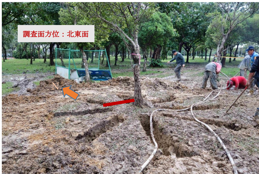
照片 4-6 No.14 挖溝改良（放射狀） 榕樹
