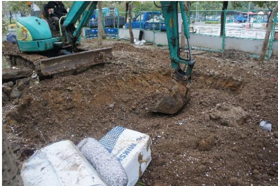
照片 2-26 鄰接的現場土壤使用于改良用土壤
