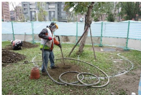
照片 2-40 用空氣挖掘機開始挖掘
