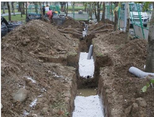
照片 2-24 排水層鋪設和設立酸素管
