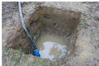
照片 2-58 用水泵排除積水
