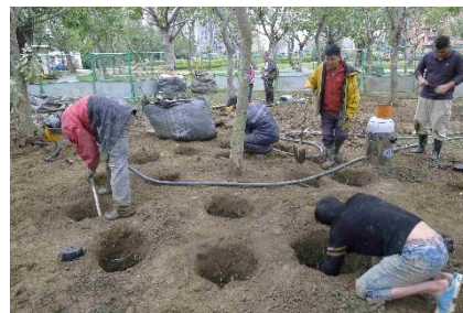
照片 2-53 用人力和吸塵器排除
