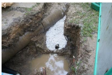
照片 2-60 深挖的排水層
