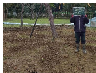
6) 改良土回填完成
