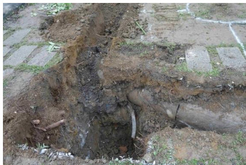
照片 5-1 No.10 區的埋設管
