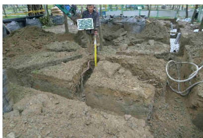
4) 完成放射狀，連續溝挖掘
