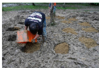
4) 用改良土壤回填
