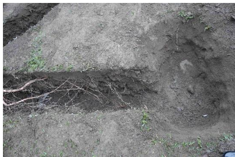
照片 2-14 挖掘土壤排放溝
