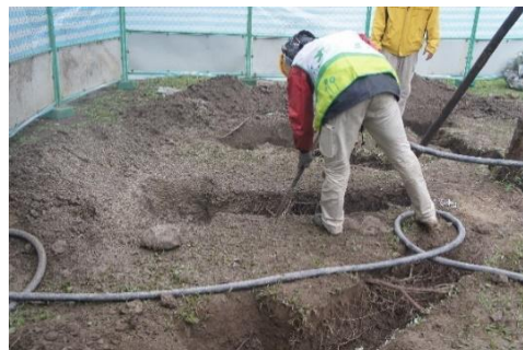
照片 2-15 用空氣挖掘機挖掘
