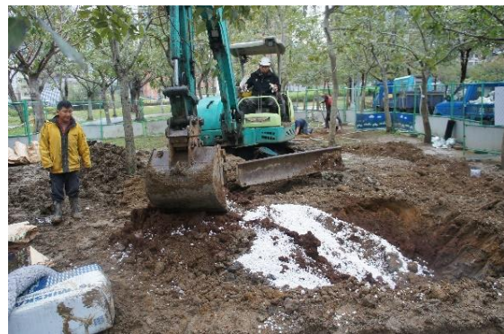
照片 2-27 土壤改良材的混合
