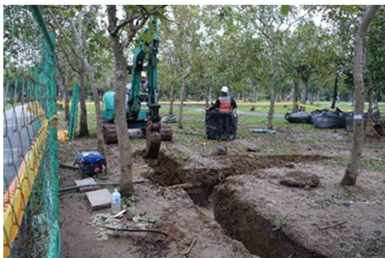
照片3 連續溝土壤改良區的連續溝開挖狀況 左側的樹木為連續溝改良工法的試驗對象樹木。 離樹幹 1m 處以挖土機挖掘連續溝。
